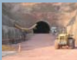
Under construction. © FIVAS and Proyecto Gato.
