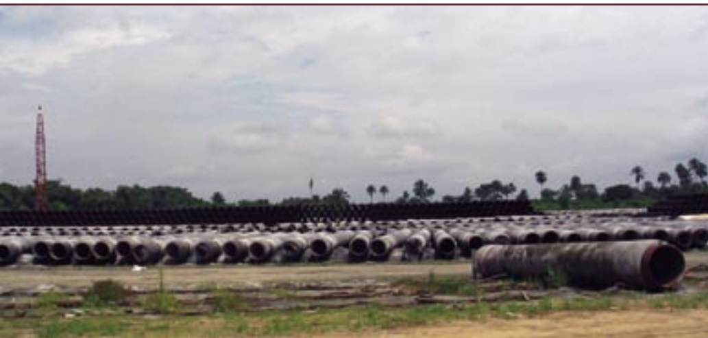
Ductos para el gasoducto entre Nigeria y Ghana.
